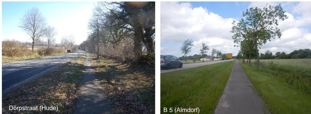
Abb. 7-7: Beispiele für bestehende straßenbegleitende Radverkehrsanlage mit Ausbaubedanken aufgrund zu geringer Wegebreiten
