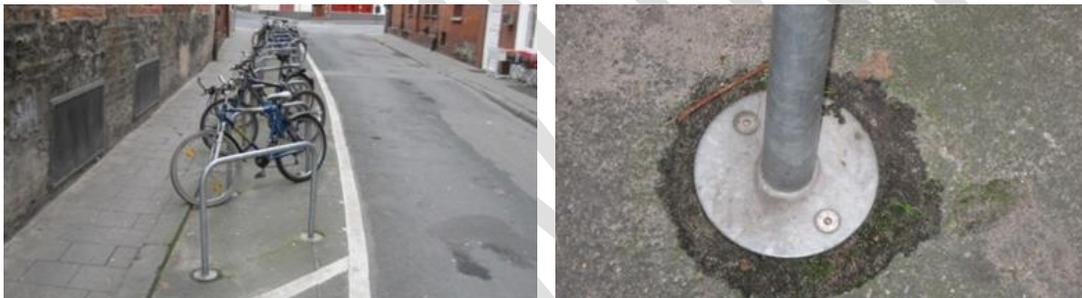
Abb. 8-2: Beispiele für verschraubte Rahmenhalter (Lüneburg)
